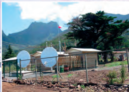
Iles Juan Fernández (Chili), site commun de la station de surveillance hydroacoustique HA3 et de la station de surveillance des infrasons IS14. L'encart montre l'installation à terre de la station HA3 et le système central d'enregistrement de la station IS14 avant qu'ils ne soient détruits par un tsunami en 2010.
