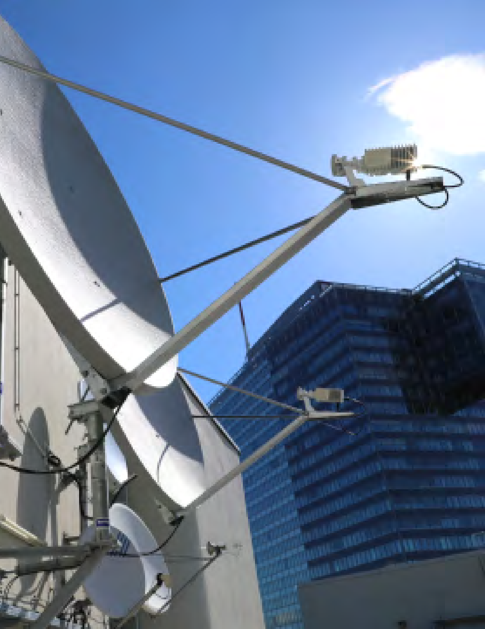
在奥地利维也纳国际中心楼顶上安装全球通信基础设施三。
