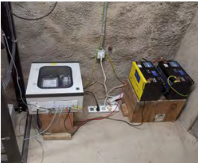
Ремонтно-восстановительное обслуживание станции AS030 (Эфиопия) при финансировании ЕС
