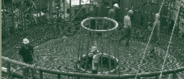
SE PONEN LOS CABLES PARA LA ESTACIÓN HYDROACÚSTICA (HA05) EN MARTINICA, FRANCIA
