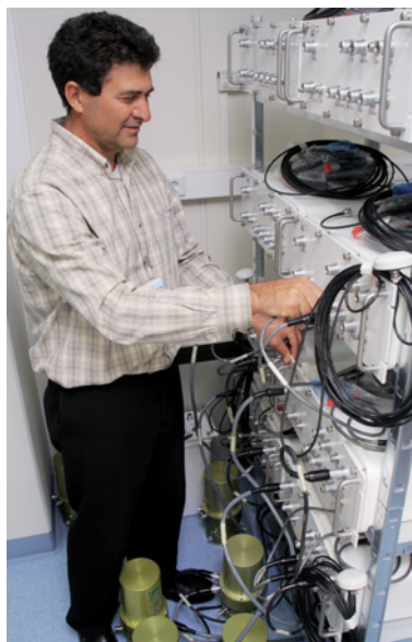
Preparación y ensayo del equipo de una estación infrasónica.
