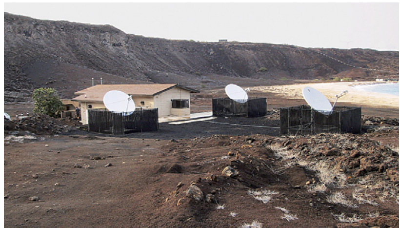
Instalación central de grabación y antenas de comunicaciones satelitales de la estación hidroacústica HA10, Ascensión (Reino Unido).
