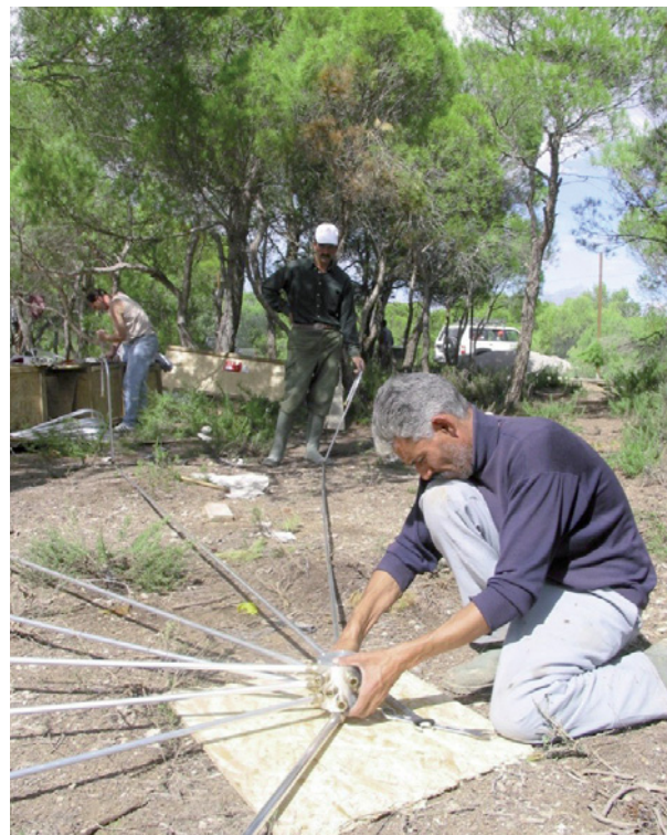
Primera instalación del complejo de tubos prefabricado suministrado por la STP, estación infrasónica IS48, Kesra (Túnez).
