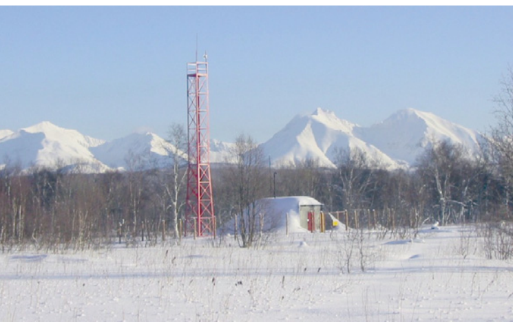
Elemento del complejo de la estación infrasónica IS44, Petropavlovsk-Kamchatka (Federación de Rusia).
