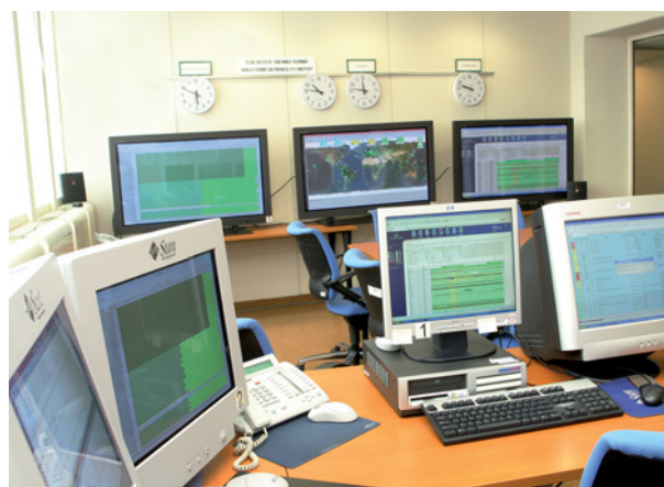
Centro de Operaciones de la STP.
