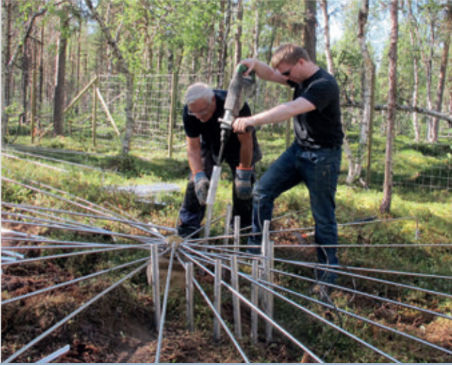
在挪威巴杜福斯次声台站 IS37 安装管阵列。
