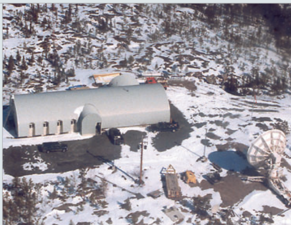
Первичная сейсмическая станция PS9, Йеллоунайф, Северо-западные территории, Канада.
