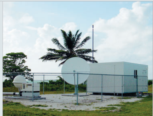
Радионуклидная станция RN8, Кокосовые острова, Австралия.
