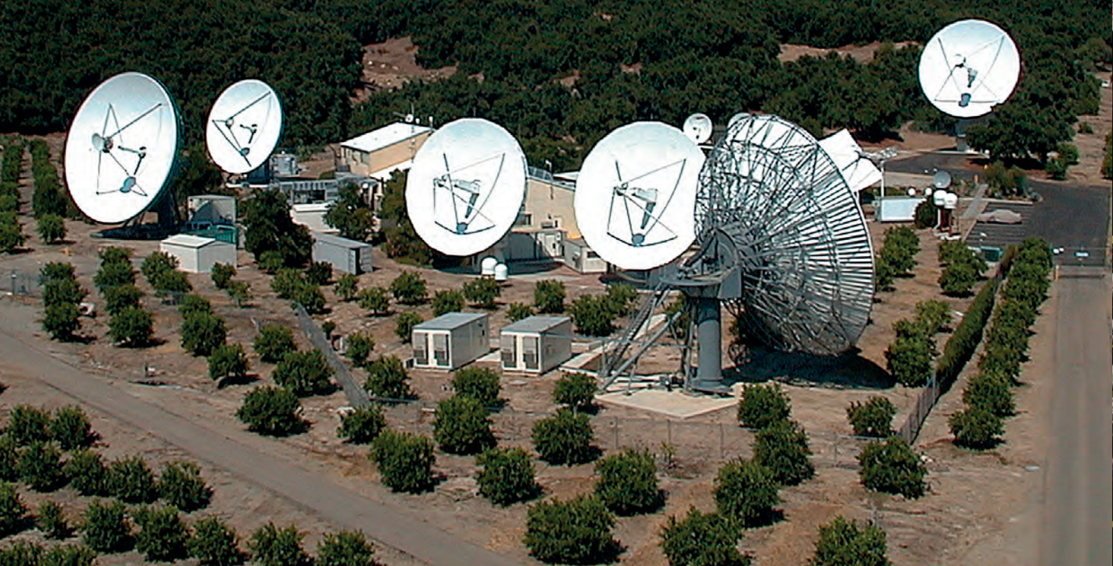
向全球通信基础设施提供服务的通信港之一，美国南加利福尼亚圣保拉通信港。它连接六个卫星区域中的三个区域：太平洋、北美和中美洲及北太平洋（日本）。
