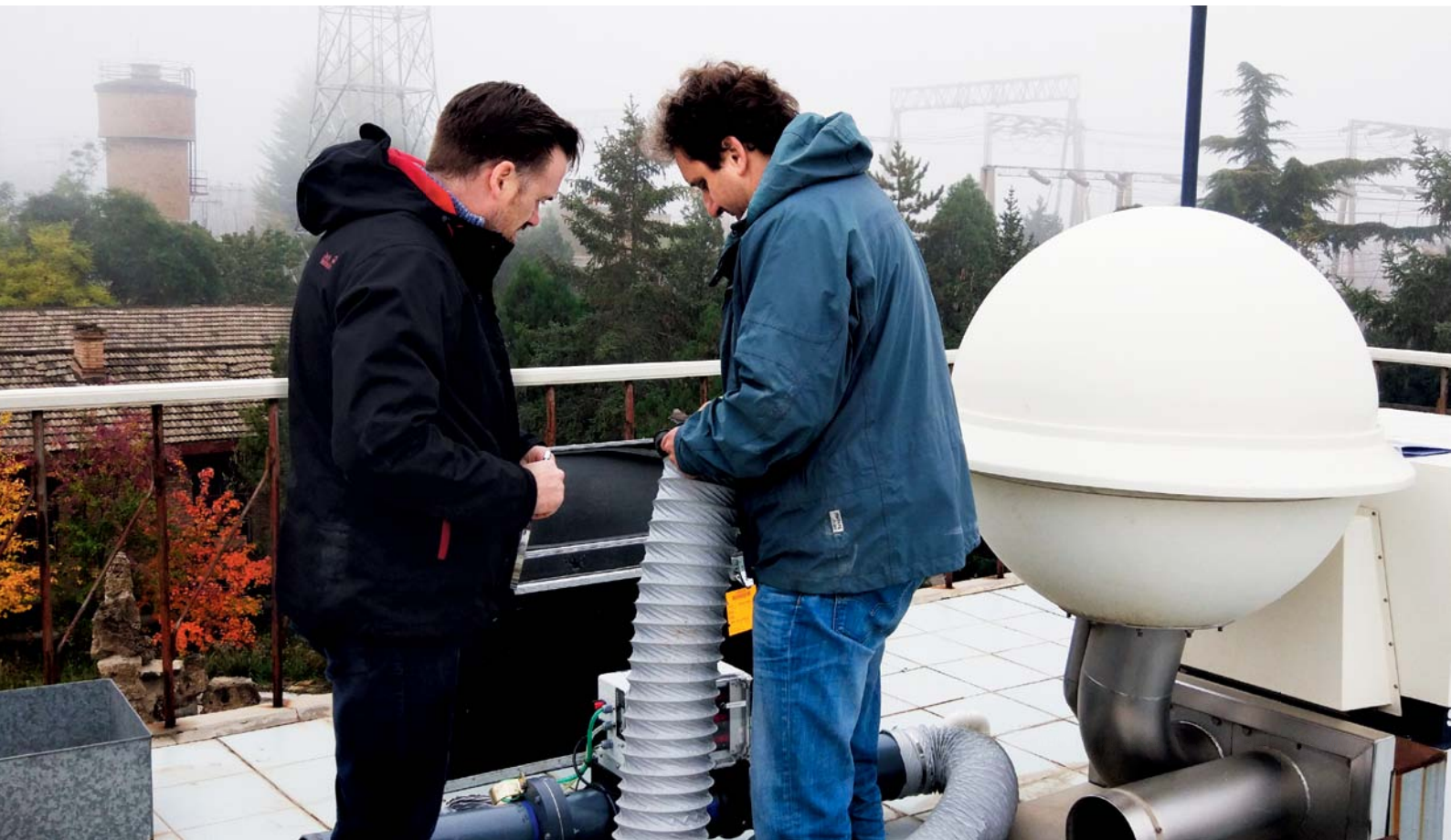
تركيب محطة رصد النويدات المشعة RN21، لانتشو (الصين).
