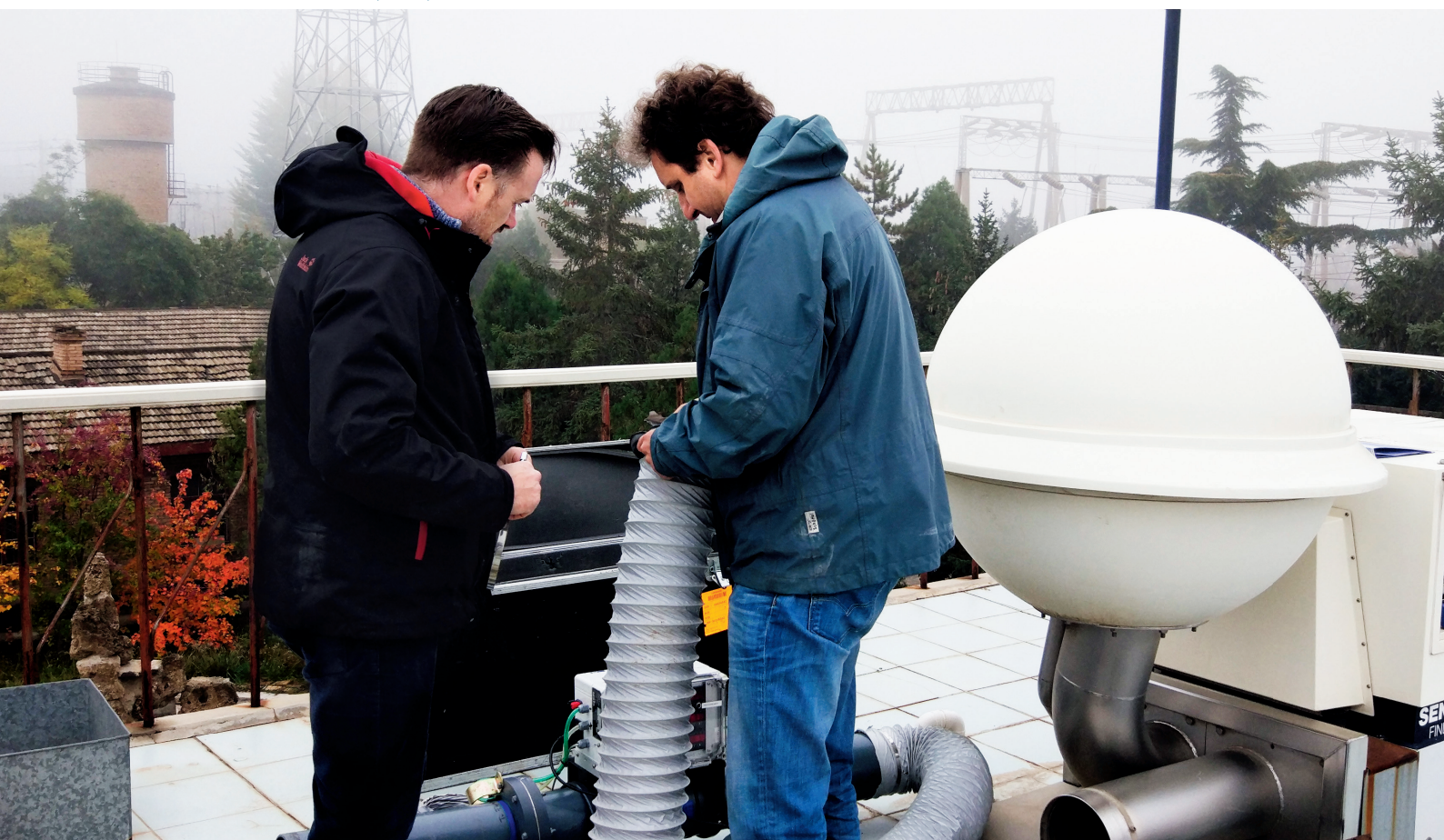
Installation de la station de surveillance des radionucléides RN21, Lanzhou (Chine).
