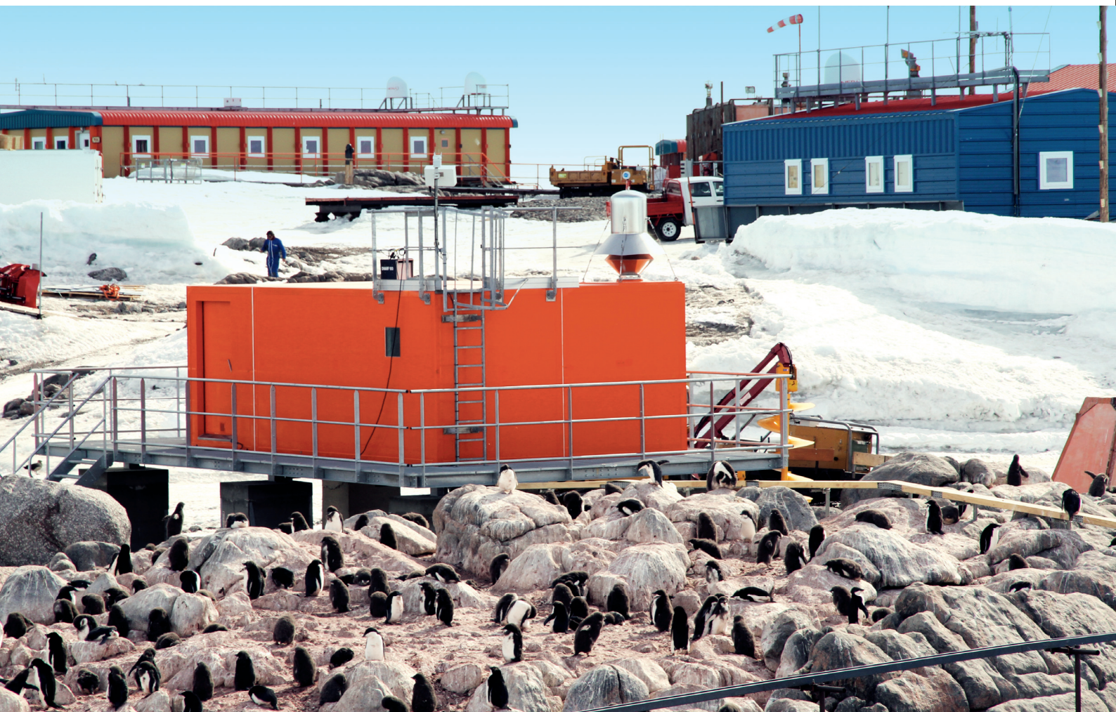
Station de surveillance des radionucléides RN32, Dumont d'Urville, Antarctique (France).
