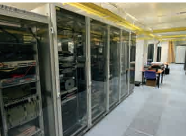
Arriba: Instalación del terminal de satélites de la IMC en el CND de Abuja (Nigeria).
