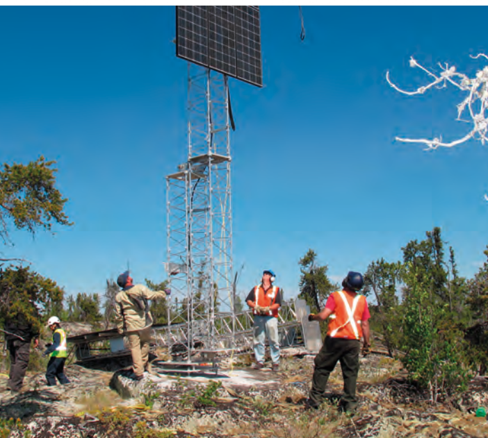
Работа по модернизации первичной сейсмической станции PS9 (с группой датчиков), Иеллоунайф, Северо-Западные территории, Канада. Слева: Установка солнечных панелей. Справа: Монтаж шкафа для укрытия оборудования.
