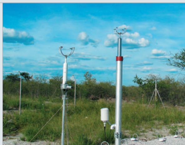
Instalación del equipo para la verificación de datos meteorológicos durante una visita de homologación a la estación infrasonica IS35 de Tsumeb (Namibia).
