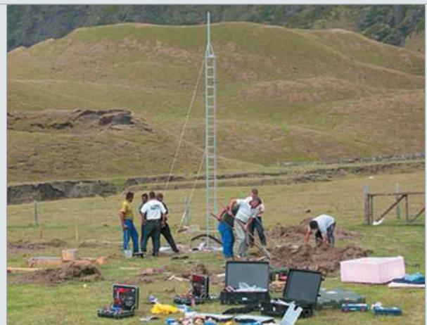
Preparación del emplazamiento para la estación infrasónica IS49, Tristán da Cunha (Reino Unido).
