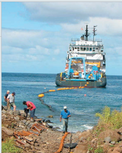
Tendido de un cable cercano a la costa en la estación hidroacústica HA3, Isla Juan Fernández (Chile). Los flotadores que lo mantienen en la superficie se retiran luego para que el cable se sumerja hasta el lecho marino.
