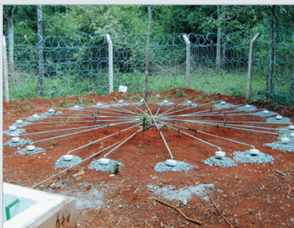
Conjunto de tubos amortiguadores del ruido eólico de la estación infrasonica IS32 de Nairobi (Kenya).
