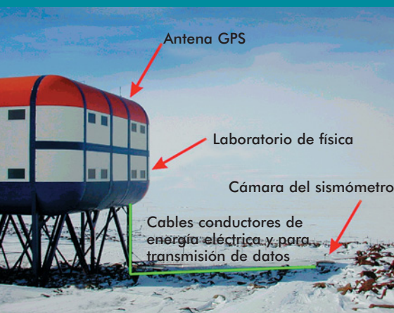
Vista de primer plano de la estación sísmica auxiliar AS35.
