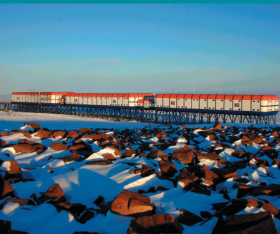
Estación sísmica auxiliar AS35, Estación SANAE, Antártida (Alemania/Sudáfrica).
