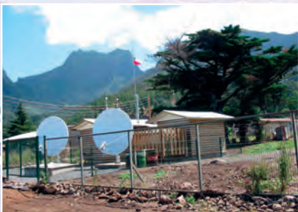
Isla Juan Fernández (Chile), emplazamiento conjunto de la estación hidroacústica HA3 y la estación infrasónica IS14. A la izquierda, imagen de la instalación en tierra de la estación HA3 y la instalación central de grabación de la estación IS14 antes de ser destruidas por un tsunami en 2010.
