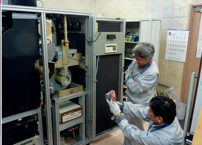
Unos operadores verifican la instalación del sistema detector de la estación RN38.
