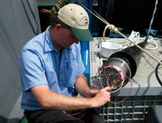
Вверху: Работы по ремонту кабелей на гидроакустической станции НАЗ на острове Хуан-Фернандес (Чили).
