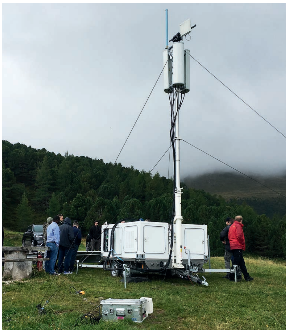
现场视察遥测设备实地检验 (奥地利)。
