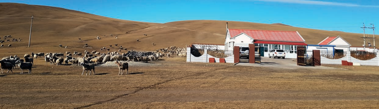
Station du réseau primaire de surveillance sismologique PS12 (Chine).
