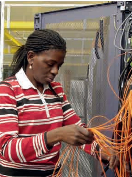
Слева: укладка волоконно-оптического кабеля для объединения сети баз данных в инфраструктуру сети хранения данных. Справа: серверы в компьютерном центре.
