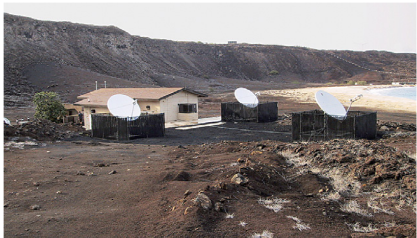
Центр регистрации данных и антенны спутниковой связи на гидроакустической станции НА10, остров Вознесения, Соединенное Королевство.
