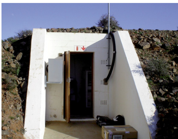
Вход в бункер, вспомогательная сейсмическая станция AS99, Сатерленд, Южная Африка.
