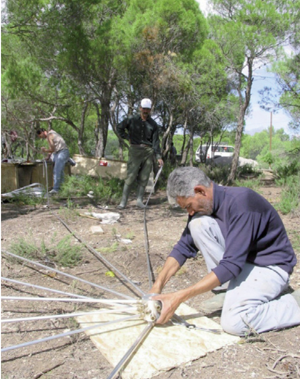
التركيب الأول لصفيحة أنبوبية مسبقة الصنع من تزويد الأمانة في محطة الرصد دون السمعي IS48، كسرى، تونس.
